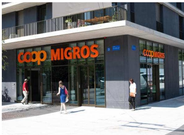
Centre commercial et logements La Sallaz
