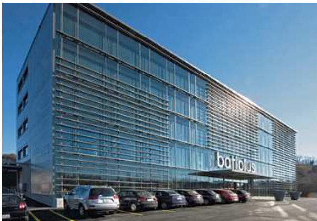
Design Center Puidoux
