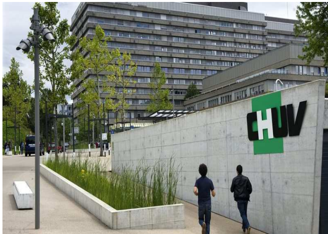
Blocs opératoires du CHUV Lausanne
