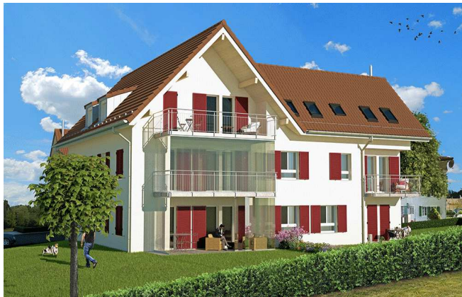
Résidence «Autour du Tilleul» Fey
